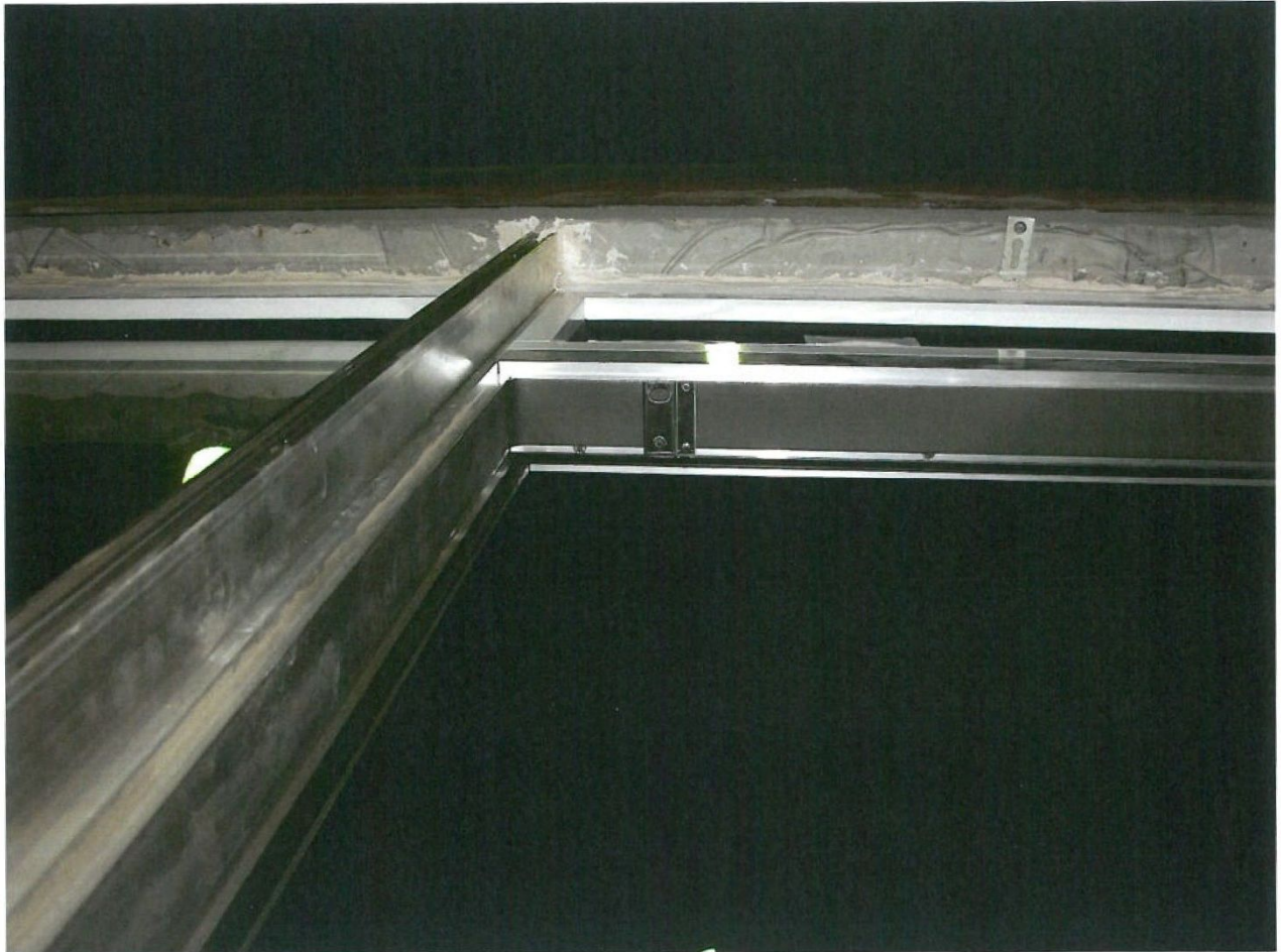
Foto. 5. Ansicht des Prüfkörpers vor der Prüfung (Detail)
