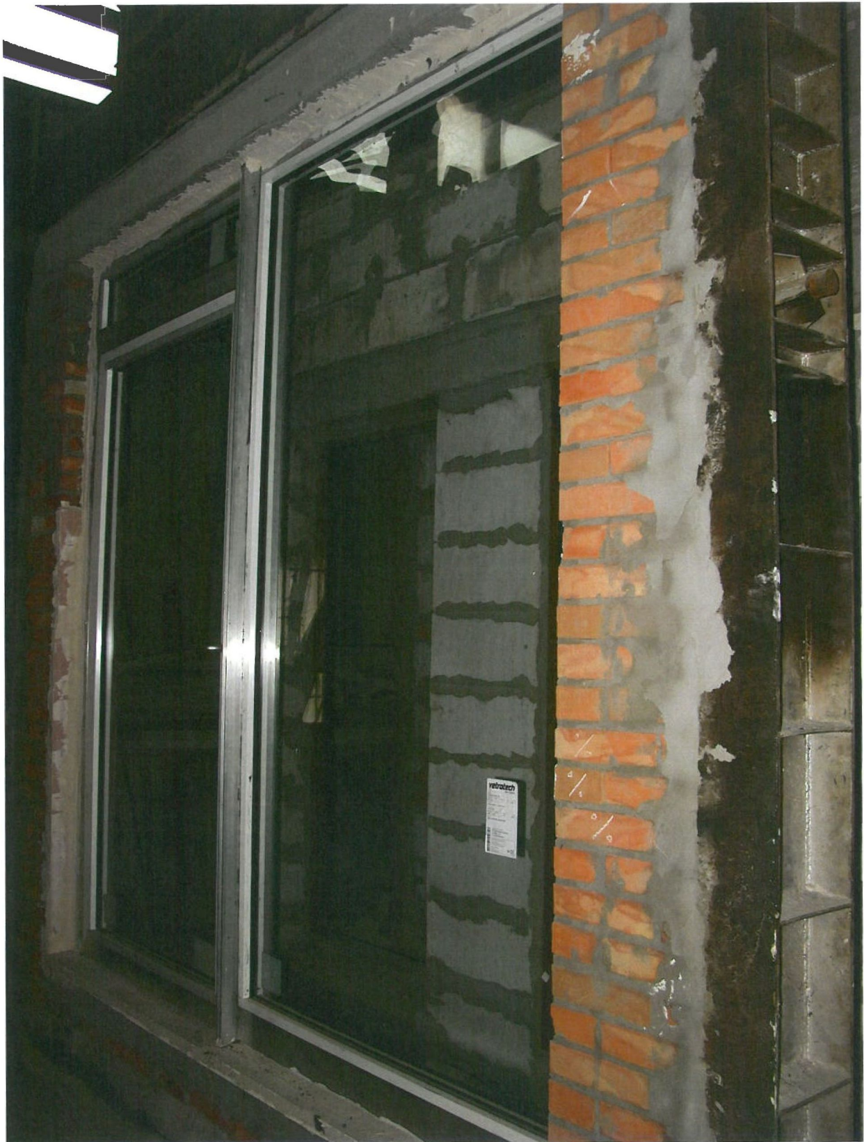
Foto. 1. Ansicht des Prüfkörpers von der beheizten Seite vor der Prüfung,
