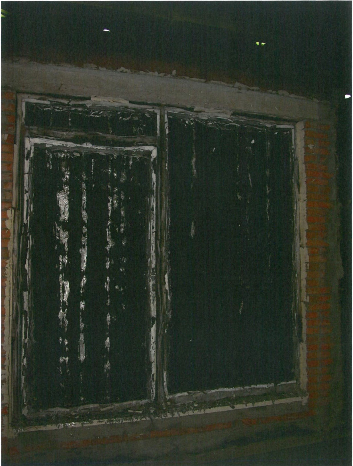
Foto. 9. Ansicht der beheizten Oberfläche des Prüfkörpers nach der Prüfung
