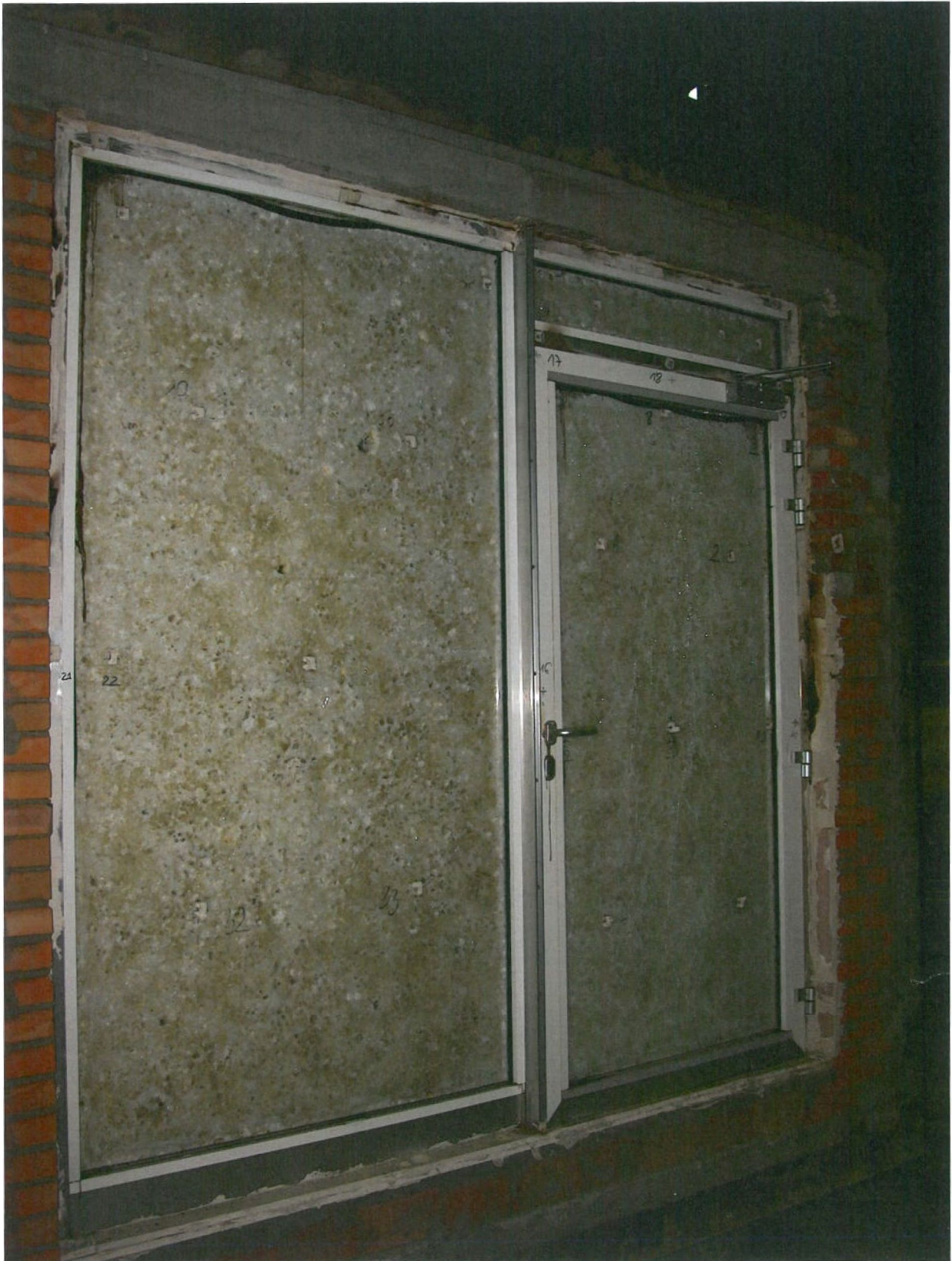
Foto. 10. Ansicht der nicht beheizten Oberfläche des Prüfkörpers nach der Prüfung
