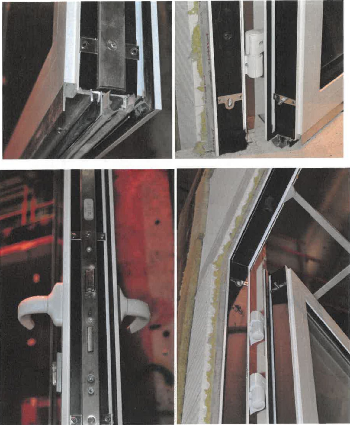
Foto 3. Oberflächenansicht des Prüfkörpers Nr. 1 vor der Prüfung - Details
